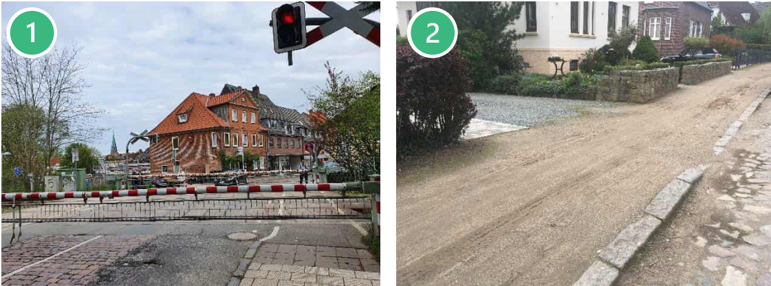
Abbildung 59: Bahnübergang Weidestraße (links), Bürgersteig Vahldiekstraße (rechts). (© ZEBAU GmbH)
