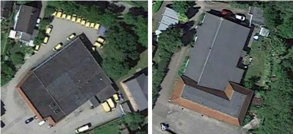
Abbildung 58: Gewerbegebäude mit großen PV-Potenziale (Bildquelle: Google Satellite)
