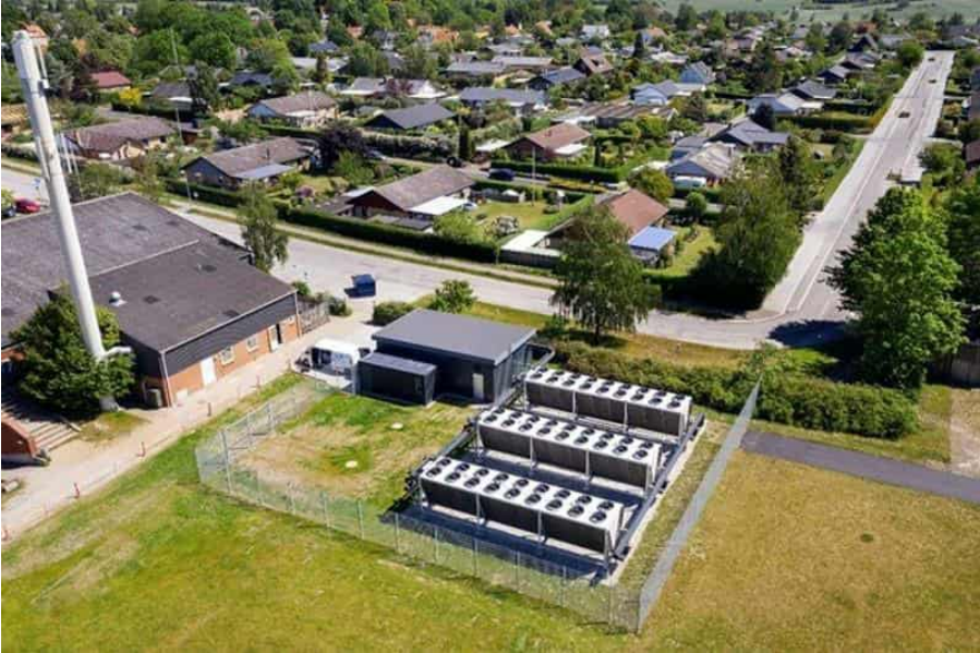
Abbildung 51: 1-MW Luftwärmepumpe in Dänemark (Urheber PlanEnergi)
